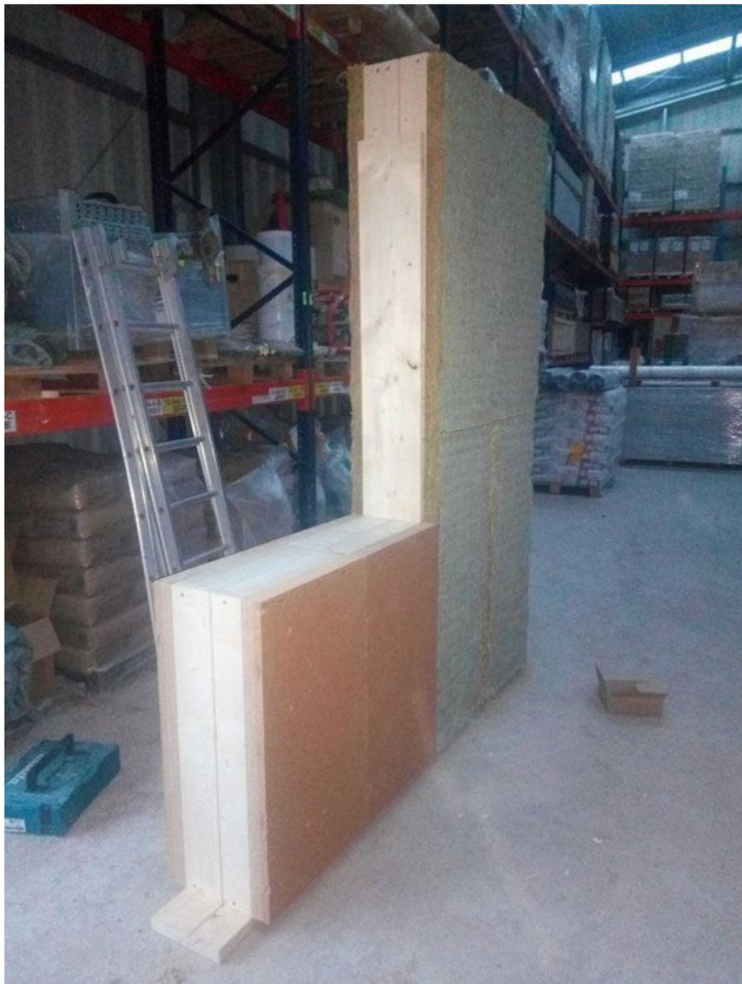
Réalisation des murs, ici 2 modules et 2 allèges de 50kg maximum, 50cm de largeur 250cm de hauteur pour le module et 100cm pour l'allège, ossature remplie d'isolant sur 24cm + 1 panneaux d'isolant à enduire de 6cm sur chaque face, une version avec panneau fibre de bois et une version avec panneau paille.
