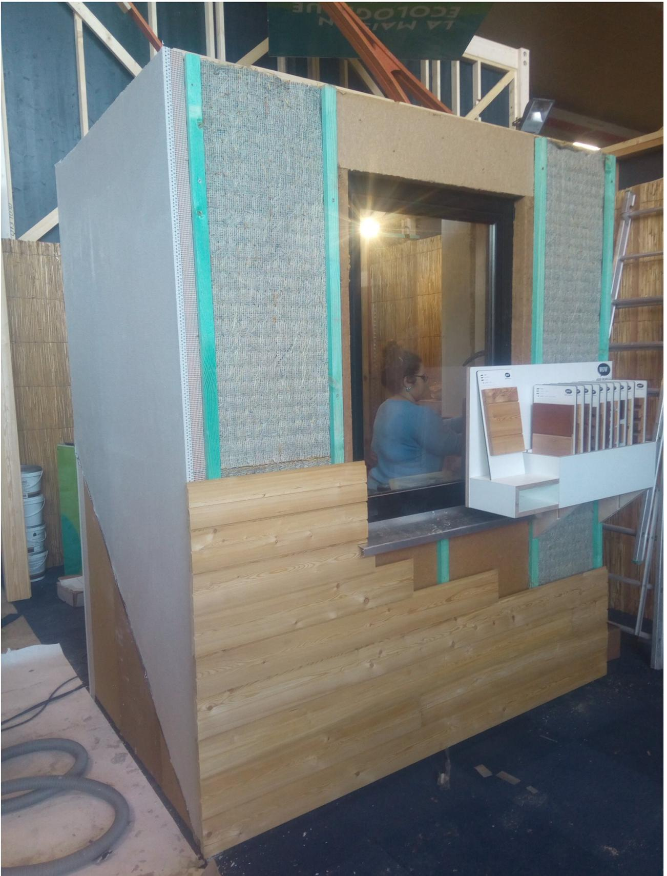
Maquette finie avec tous les détail techniques murs -allèges-linteau- cloison- enduit extérieur – bardage – enduit terre et enduit plâtre intérieur. Le système autorise au choix une multitude de finitions intérieures et extérieures.
