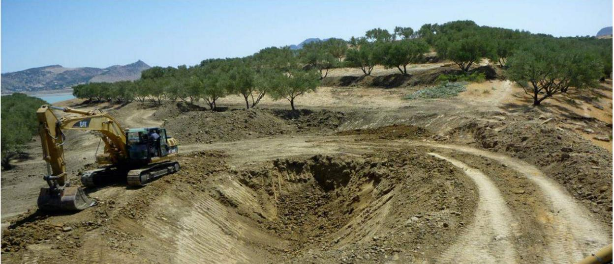
Une pelle mécanique est utilisée pour excaver et charger de la terre et des matériaux en vrac. Elle dispose d'un bac rotatif pour sols durs, et autres dispositifs spéciaux.
